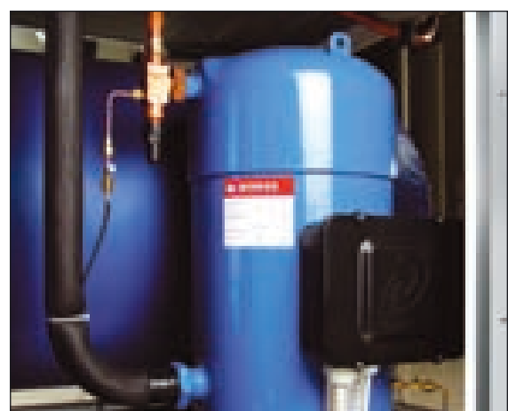
Scroll compressor. Compressore Scroll.
