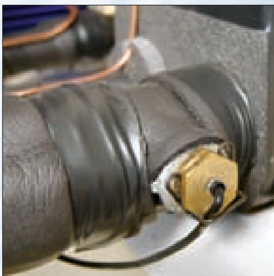
Antifreeze sensor. Sonda antigelo.
