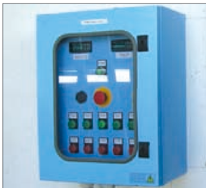
Control panel. Quadro di controllo.
