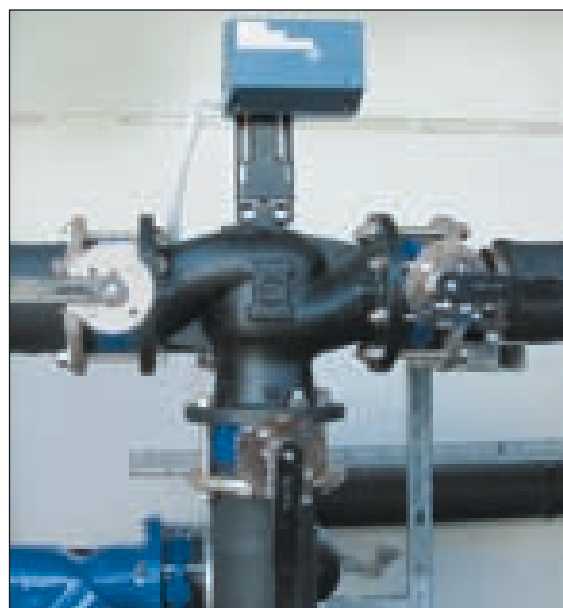
Thermostatic valve with servo control. Valvola termostatica con servocomando.
